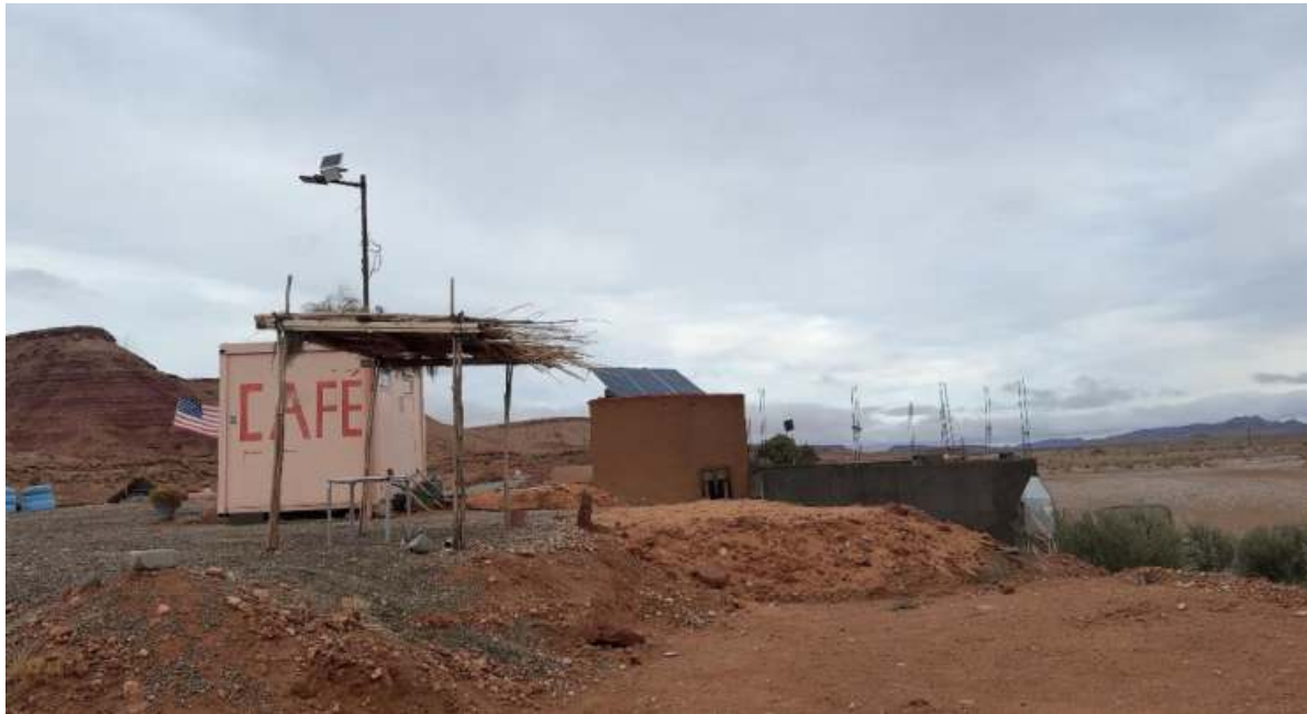
Ajubs Cafe mit seinen Solaranlagen, die auf dem Dach stehen.
