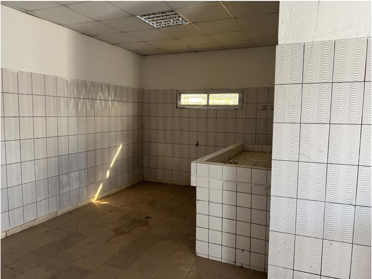
Die ehemalige Leichenhalle steht restlos leer.
