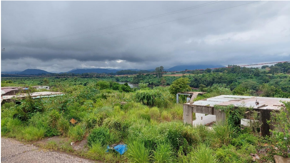
Zerstörte Häuser am Flussufer des Rio Taquari. Der Flusspegel ist hier während der Flut mehr als 20 Meter gestiegen. Foto: Teresa Liesenfeld
